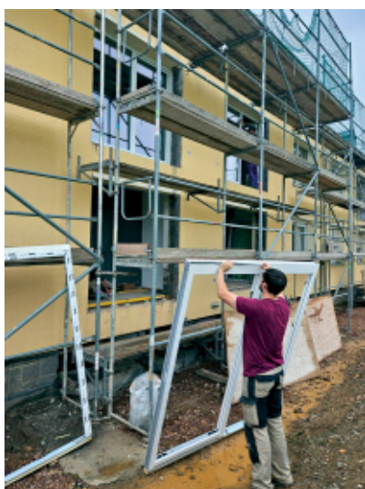
Florian Triemer baut die neuen Balkontüren und Fenster ein.
