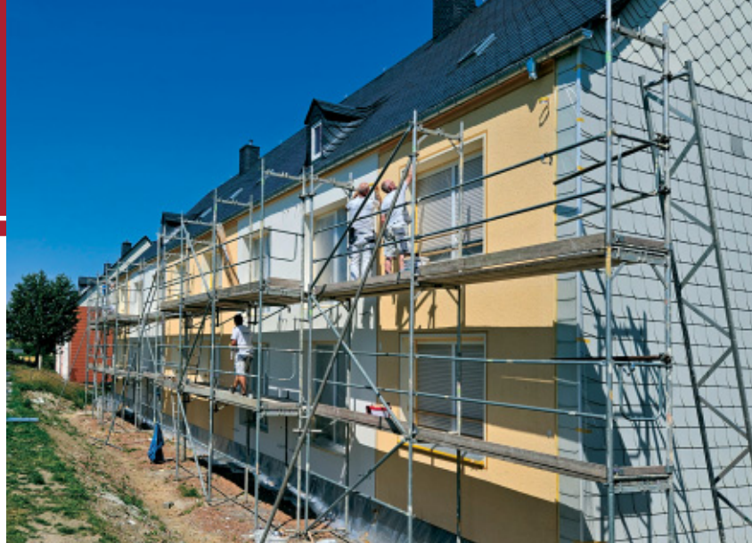
Rutenweg 28/30 vor Balkonanbau. Die Fa. Werner an der Fassade.
