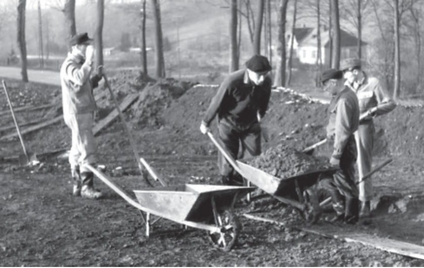
1956 Hier hat alles begonnen. Schachtung für Haus Rutenweg 50.
