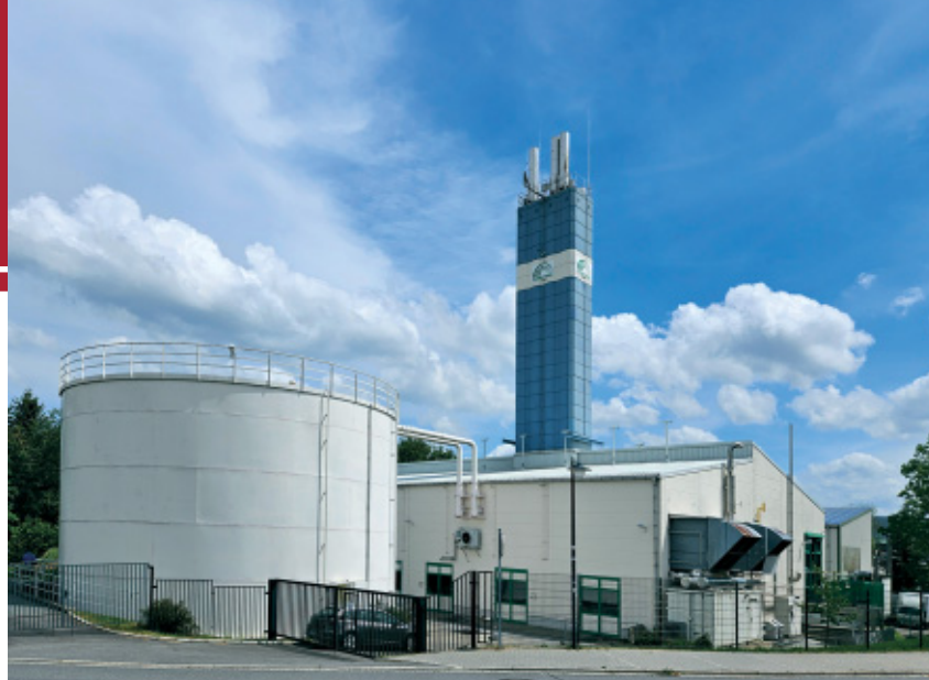
Das Heizwerk, wo neben elektrischem Strom Wärme erzeugt wird.
