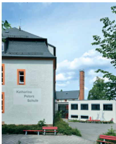
Das Heizwerk für Breite Str. und Rutenweg der FVZ in der Schule.
