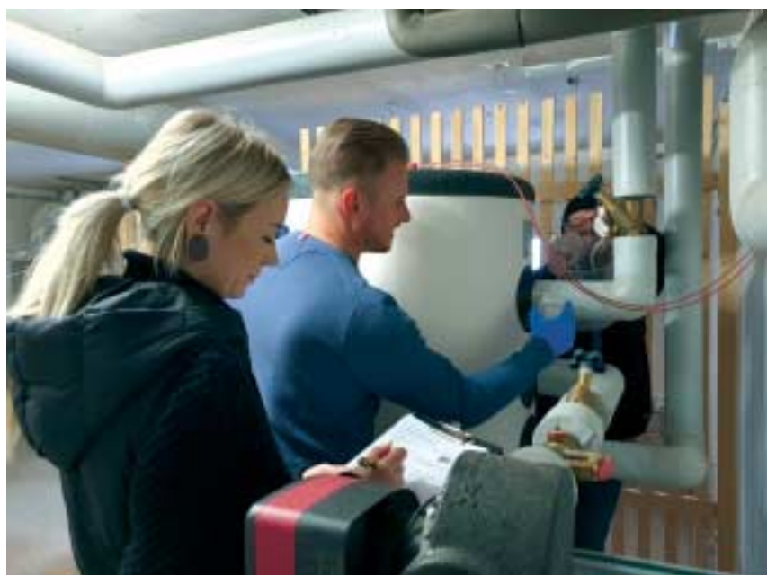
Christian Hermann und sein Team der Fa. Hygieneprofi bei der besagten Probeentnahme am Vor- bzw. Rücklauf der Zirkulationsleitung.
