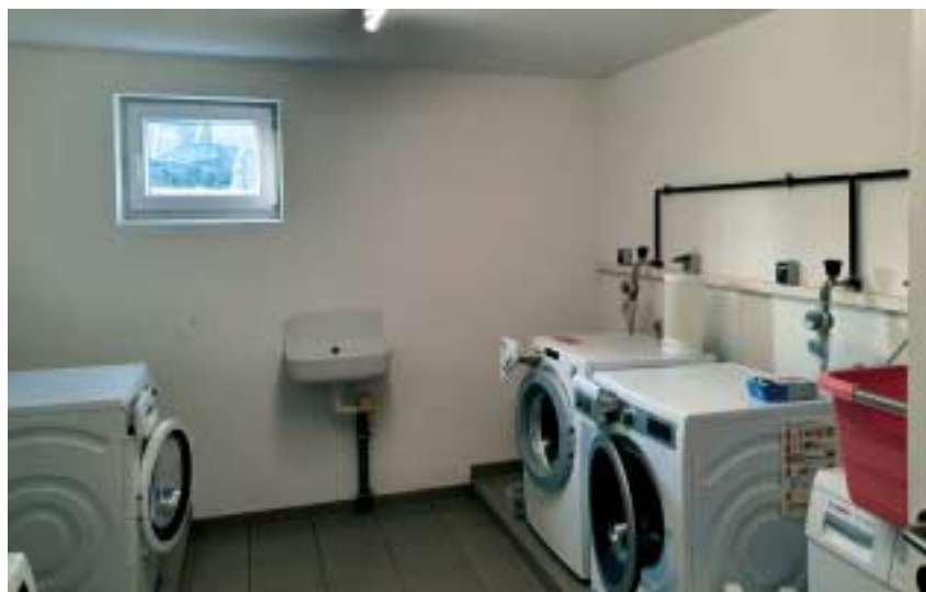
Ein Waschmaschinenraum in der Franz-Schubert-Straße 7b.
