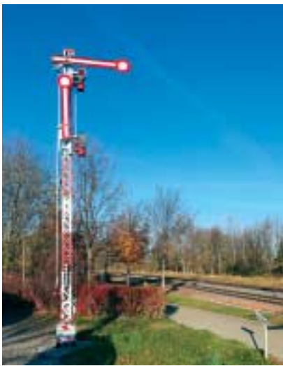
Das wiedererrichtete alte Signal am Bahnübergang.
