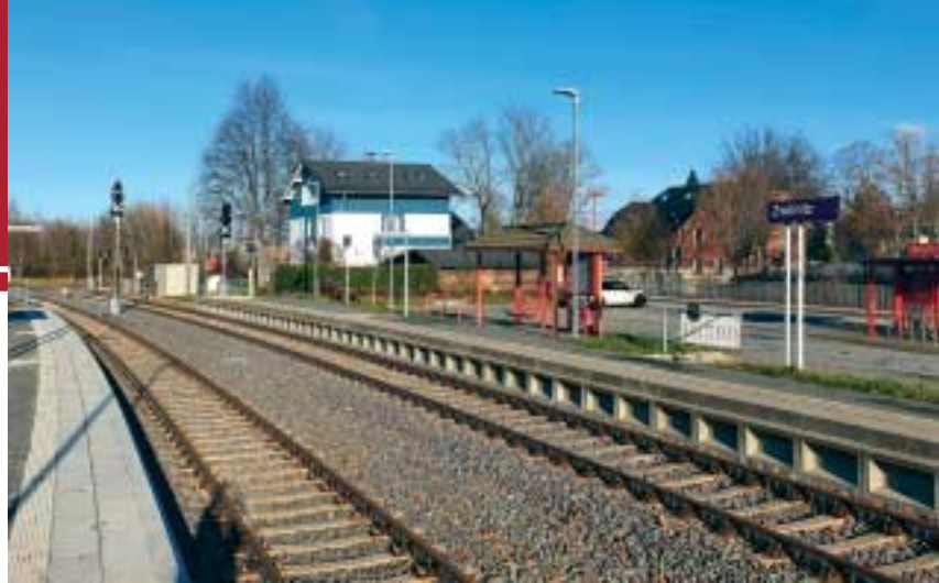
Der neue jetzt zweiseitige Zwönitzer Bahnhof / Haltepunkt.
