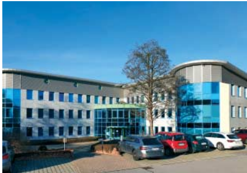
Der Sitz des ZWW am Wasserwerk 14 in Schwarzenberg.
