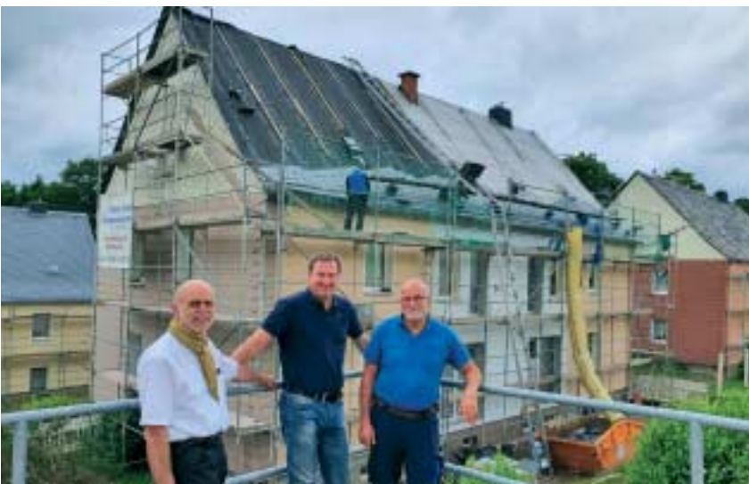
Dachsanierung Rutenweg 48. Im Bild v.l. Michael Göckert, Tim Schneider und Dachdecker Andreas Singer.
