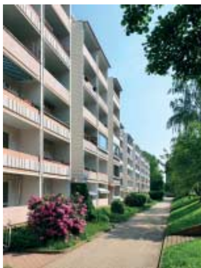
Die Wohnwege sind nicht mit schwerem LKW zu befahren.
