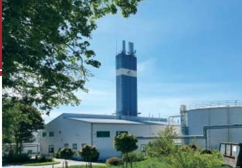
Das Heizhaus der Fernwärmeversorgung in Zwönitz.
