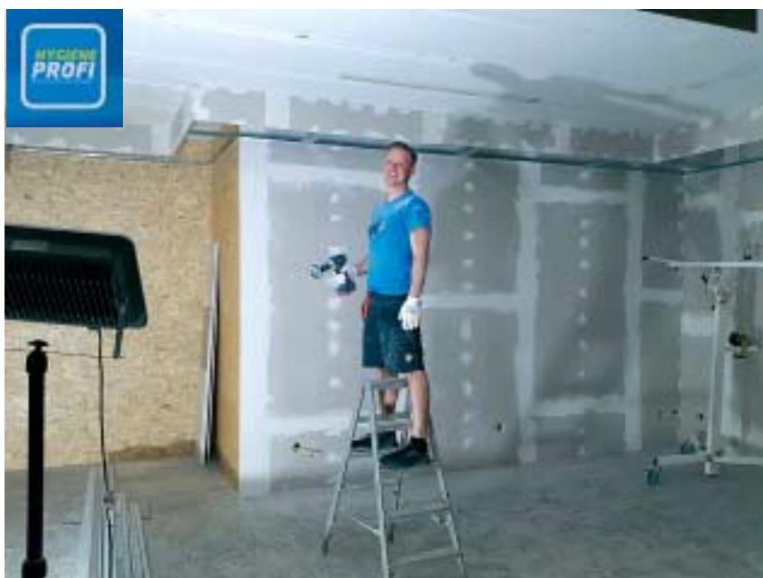
Christian Hermann beim Trockenbau im alten Gaststättenlager.
