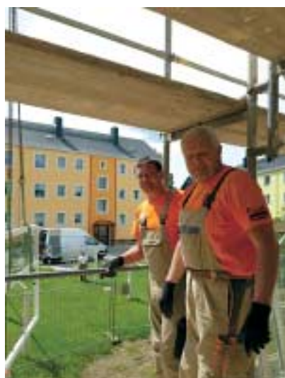
Andreas Collnitz (r.) und Mirko Geißler beim Einbau der neuen Balkontüren Breite Straße 20.
