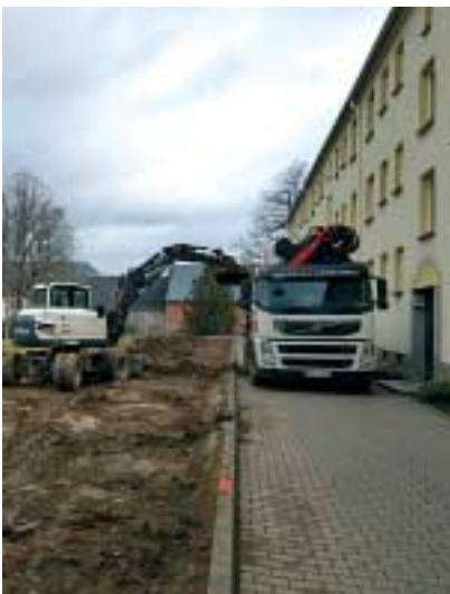
Bereits im zeitigen Frühjahr ging es mit dem Parkplatzbau Breite Straße 18-24 los.
