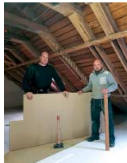
Enrico Groß und Dominic Becher, Fa. Schneider, bei der Bodendeckendämmung Markt 2.
