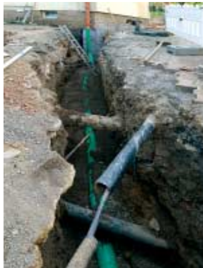
Wie schwierig der Tiefbau mitunter sein kann, zeigt dieses Bild. Hier hilft oft nur noch Handschachtung.
