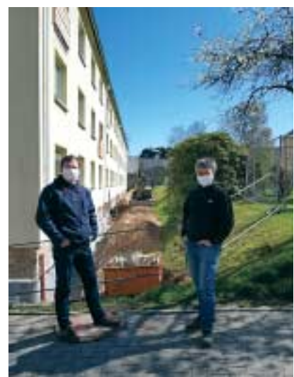
Auch auf Baustellen sind Corona-Regeln zu beachten. Tim und Martin Schneider (r.) vor Ort..
