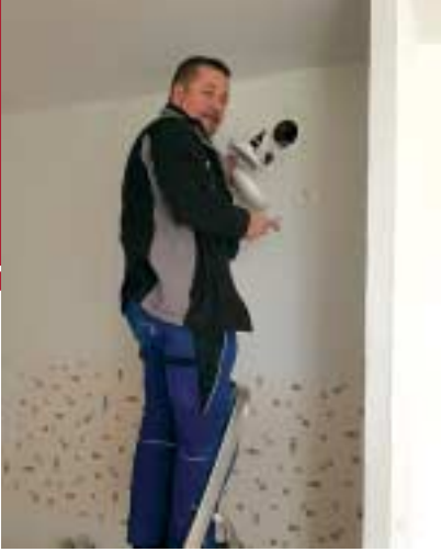
Matthias Junghans von der Fa. Nebel bei der überaus notwendigen Lüftungswartung.
