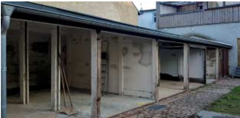
Die Garagen unterhalb des Poststalls werden für die Mieter hoffentlich bald zur Verfügung stehen.
