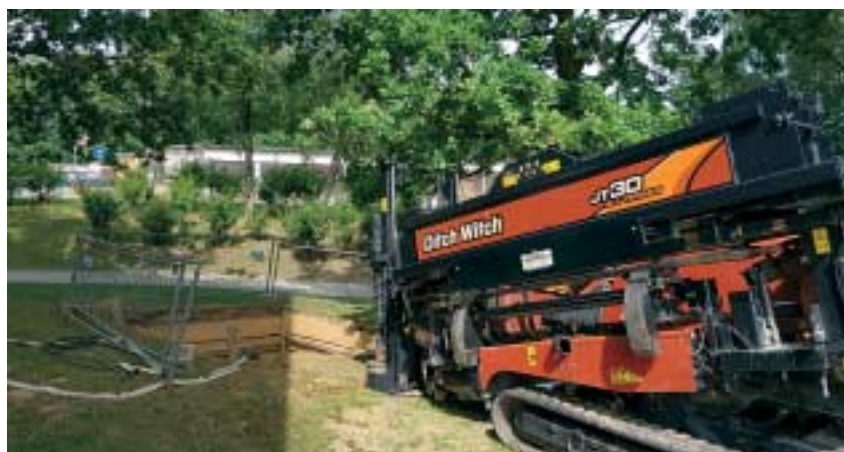
Die Technik der Fa. Pompe aus Hohenstein/Ernstthal im Einsatz am Bohrloch.
