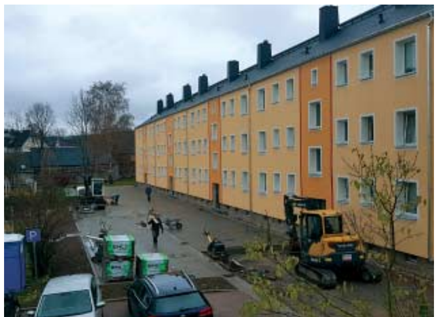
Die Mitarbeiter der Fa. Schneider beim Pflastern des Wohnweges Mitte November 2019.
