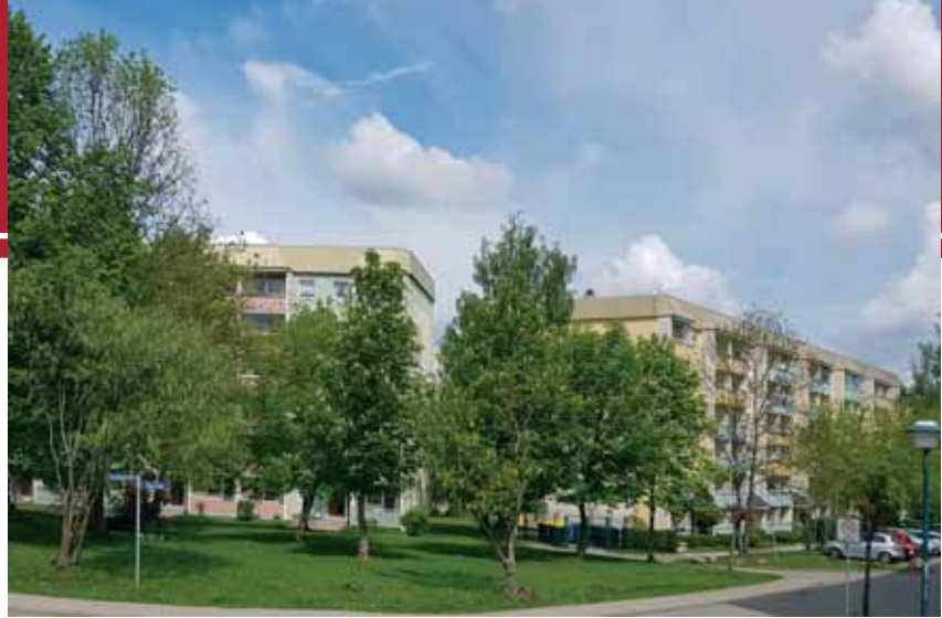
Die beiden Eigentümerobjekte. Links Lessingstraße 2-12, rechts Neue Straße 20-30.
