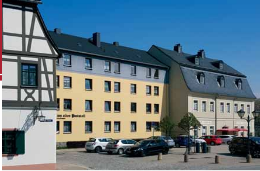
Eine aktuelle Sicht auf das Haus Markt 2 und die umliegenden Häuser. Die einstigen 12 Wohnungen wurden durch Wohnungszusammenlegungen und Grundrissveränderungen auf 10 reduziert. Jetzt sind hier auch größere Wohnungen verfügbar.
