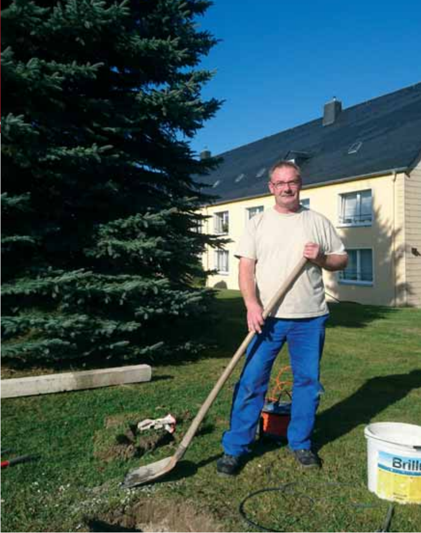
Herr Sven Günther beim Setzen neuer Wäschesäulen im Wohngebiet Rutenweg.
