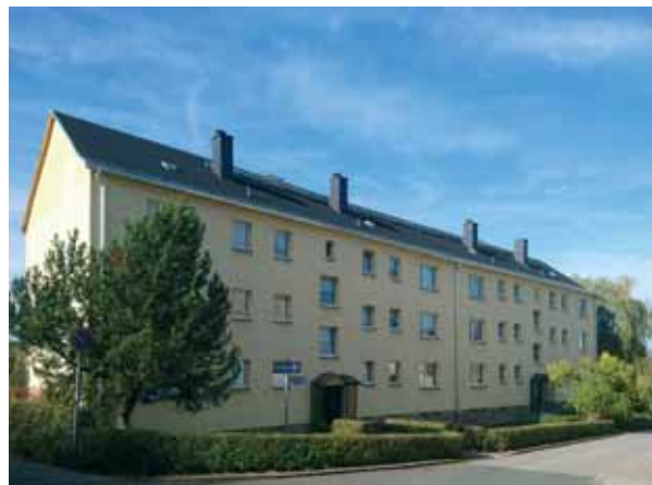
Das Haus Breite Straße 10/12 im Istzustand.
