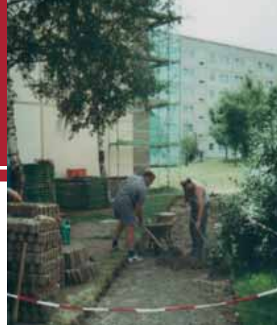
V.l. Helmut Eckardt und Rainer Goldberg beim Wegebau in der Goethestraße.
