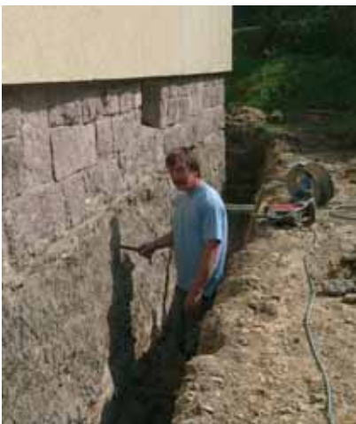
Trockenlegung am Giebel Breite Str. 12.
