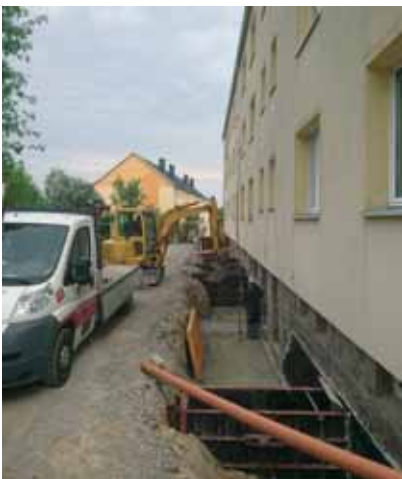
Trockenlegung und Bau der Balkonfundamente am Haus Breite Str. 10/12 durch die Fa. Schneider-Bau im April und Mai.
