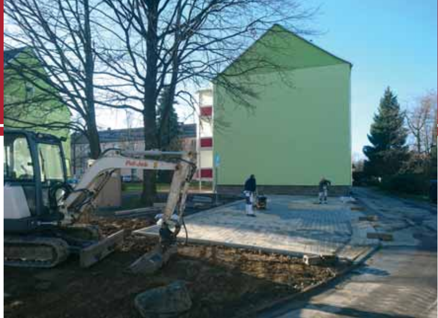
Dier erste Maßnahme des Jahres: Fertigstellung der Parkplätze am Haus Bahnhofstr. 66b durch die Fa. Schneider-Bau.
