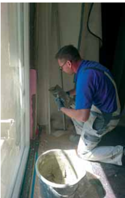
Rico Bunge von der Fa. Schneider verputzt die Laibungen.
