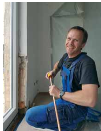
Umverlegung auch der Heizleitungen unter den Balkontüren durch Jens Hannawald (Fa. Hager).
