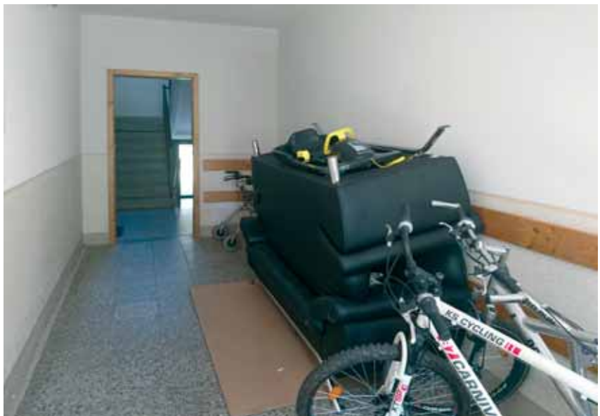
Unhaltbare Zustände unter denen Bewohner leiden und von denen reale Gefahren ausgehen!
