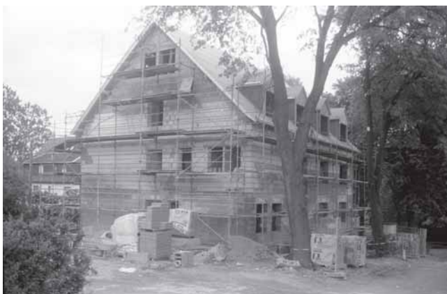
Ein Bild vom Bau des Büro- und Geschäftshauses in Kühnhaide im Juni 1994.
