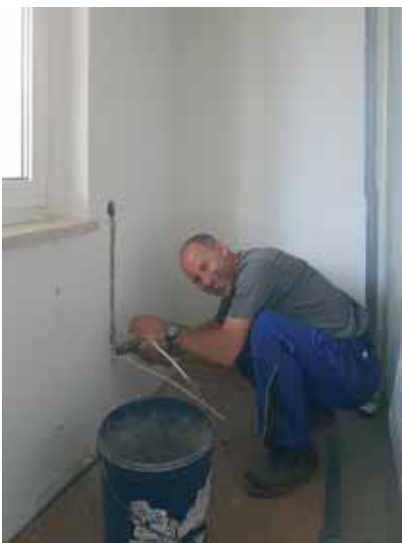
Umverlegung der elektrischen Leitungen vor dem Aufbrechen der Balkontüren durch Burkhard Baumann (Fa. Nebel).
