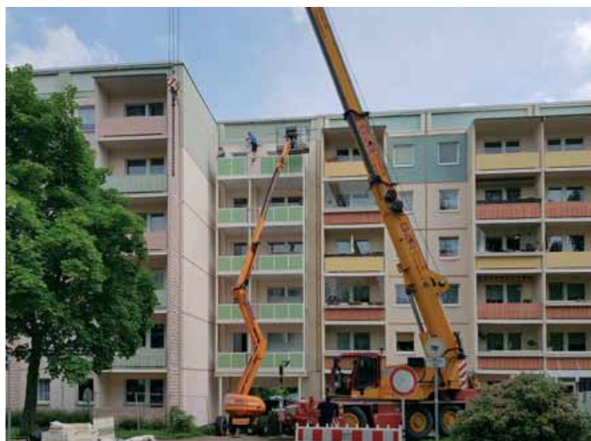
Anbau der Balkone Goethestraße 61 durch die Fa. Fischer Ende Mai-Anfang Juni.
