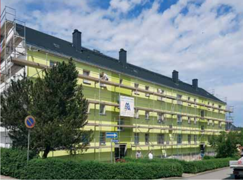
Ein neuer Farbanstrich auf der Fassade Breite Str. 10/12 durch die Fa. Werner im Mai.
