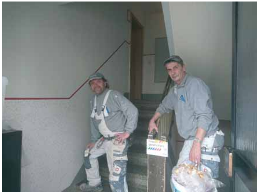
Anfang April: Treppenhaussanierung Haus Goethestraße 7 sowie der Häuser Bahnhofstr. 66 bis 66c durch die Fa. Werner.
