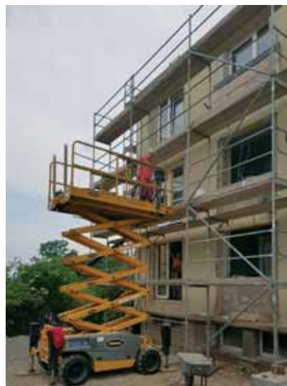
Die Außenwände werden aufgeschnitten und ausgebrochen durch die Fa. Härte 10 (Subunternehmen von Schneider-Bau).
