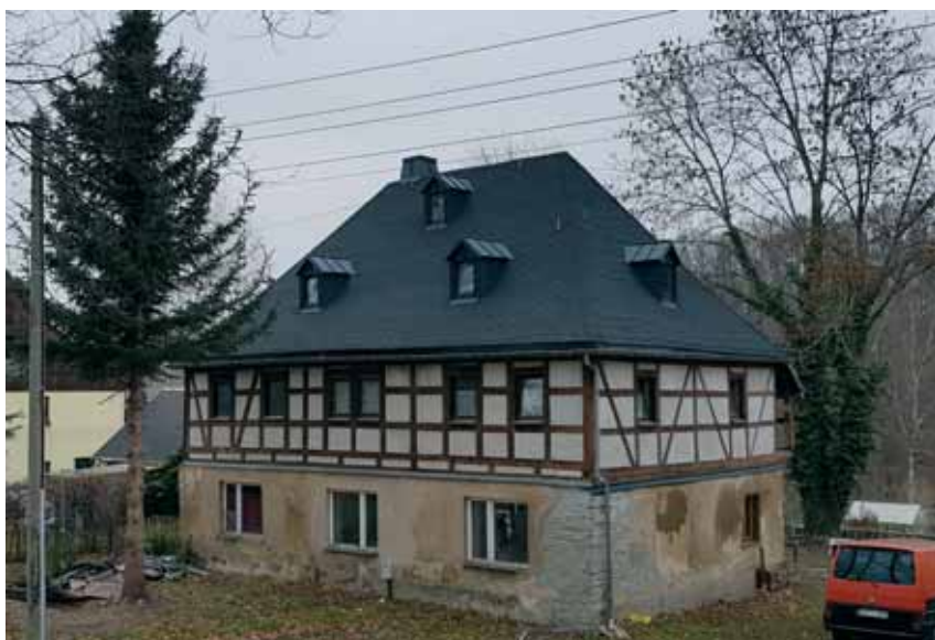
Das alte Zwönitzer „Spittel“, das einstige Armenhaus, ist mit neuem Dach vor dem Verfall gerettet!
