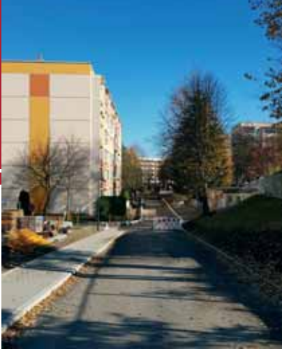
Ein Bild vom Bau aus dem November.
