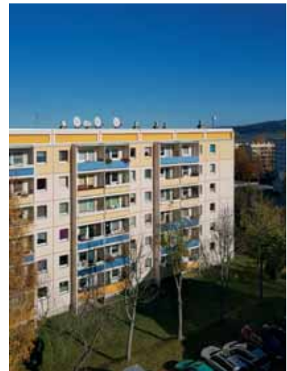
Die Antennenanlage auf dem Haus Neue Straße 2-10.
